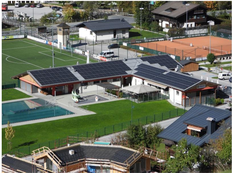
Bild: F. Hasler; PV-Anlage auf den Dächern des Freibades
